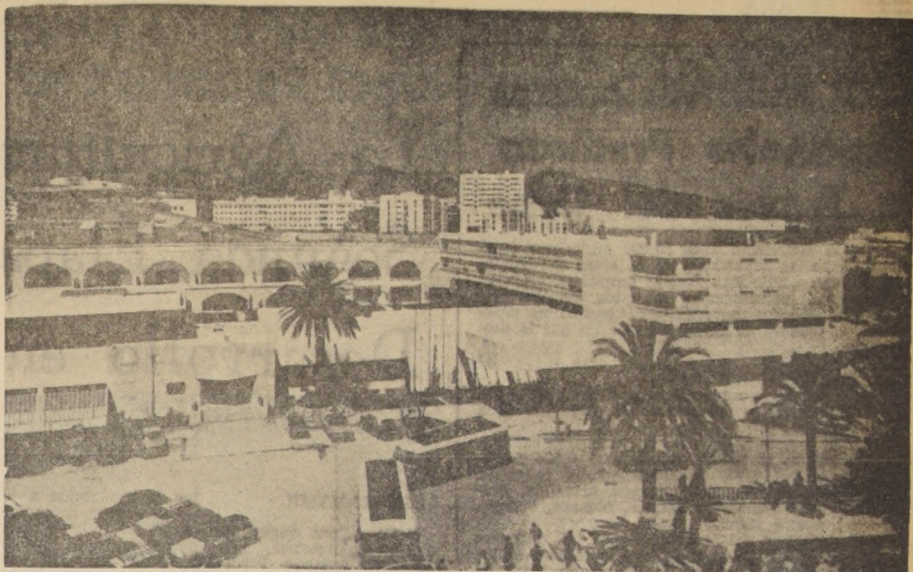
INAUGURACION DE UN GRAN HOTEL TURISTICO EN CEUTA.—Ha sido recientemente inaugurado en Ceuta, el Gran Hotel "La Muralla". Se trata de un edificio modelo en su género. Tiene 83 habitaciones, restaurante, piscina, terrazas y sala de fiestas. Está situado en la Plaza de África con vista a las históricas murallas del Foso, de ahí su denominación. En el grabado, un aspecto de dicha construcción
