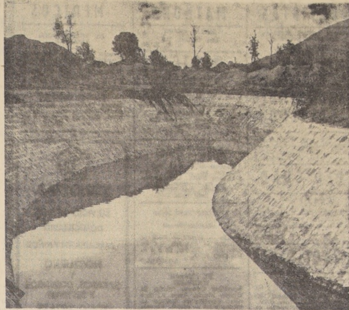
TALCA.— La información gráfica presenta uno de los canales de regadío del Sistema Maule Norte de la provincia de Talca, construido por la Dirección de Riego del Ministerio de Obras Públicas, dentro de la Alianza para el Progreso.
