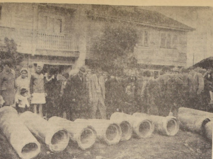
El Ministro de Obras Públicas, Sergio Ossa Pretot, ha visitado numerosos grupos habitacionales de la provincia de Cautín...
