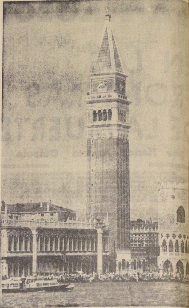
La hermosa torre de San Marcos en Venecia, que se derrumbó en 1902, encuentra otra vez en peligro. No es probable que la esbelta construcción de metros de altura se desplome inmediatamente, pero los ingenieros de la ciudad están sumamente alarmados por el debilitamiento progresivo de sus cimientos, en los cuales se han observado grietas desde hace diez años, que progresivamente van creciendo. (Foto UPI).
