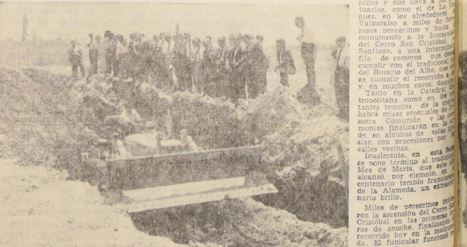
El Gobierno, los Municipios y los organismos vecinales están construyendo distintos tramos de la "Gran Avenida Americo Vespucio", camino de circunvalación que unirá las comunas del Gran Santiago. En el grabado, funcionarios y alcaldes examinan las obras y observan una demostración de movimiento de tierras realizada con los equipos especializados de la empresa Fiat.
