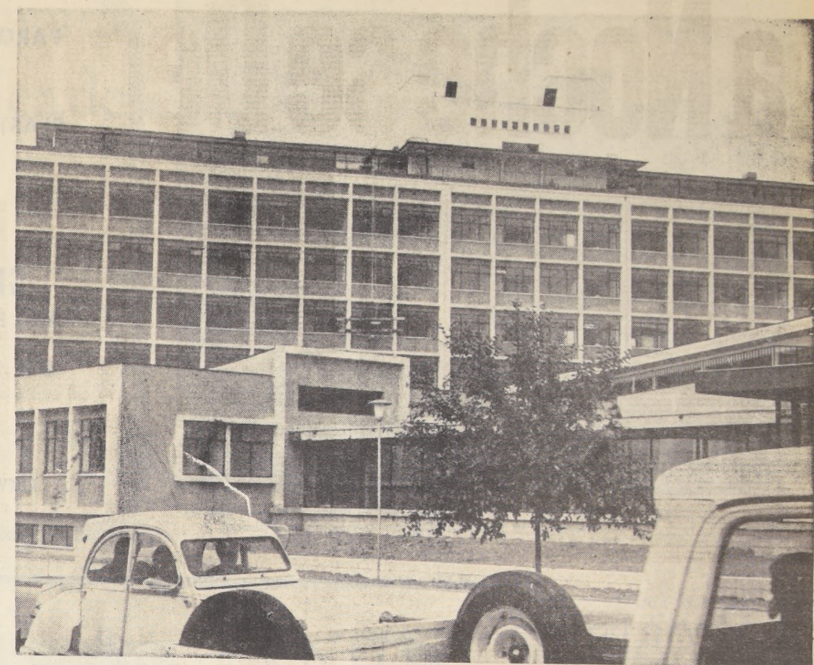
Un aspecto de la nueva Casa Central de la Asistencia Pública de Santiago.
