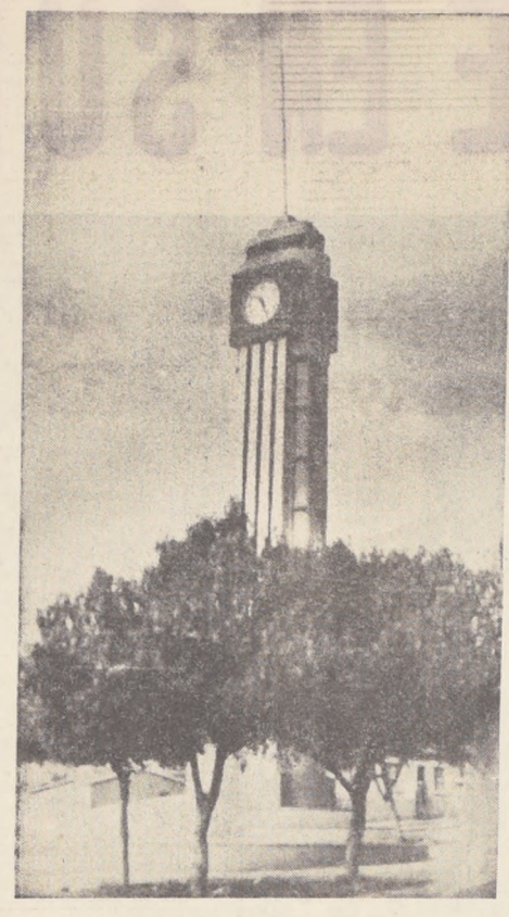
Esta torre está ubicada en Tocopilla y el reloj que aparece en ella señala la hora exacta en que se inició el terremoto que afectó al lejano puerto norteño. Como su torre, que aparece desahogada la furia de los elementos con su fuerte estructura, los habitantes de Tocopilla en estos momentos luchan con moral alta y mucho ahínco para normalizar la situación.
