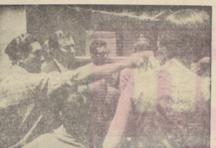
Detenida visita a los trabajos de reconstrucción de la población Gómez Carreño, de Viña del Mar, efectuó el Ministro de la Vivienda y Urbanismo, Juan Hamilton...
