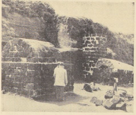
200 millones de pesos se han invertido hasta la fecha en la restauración del Fuerte Niebla. En el grabado los hornos de la fábrica de proyectiles, ya reconstruidos según modelo original...
