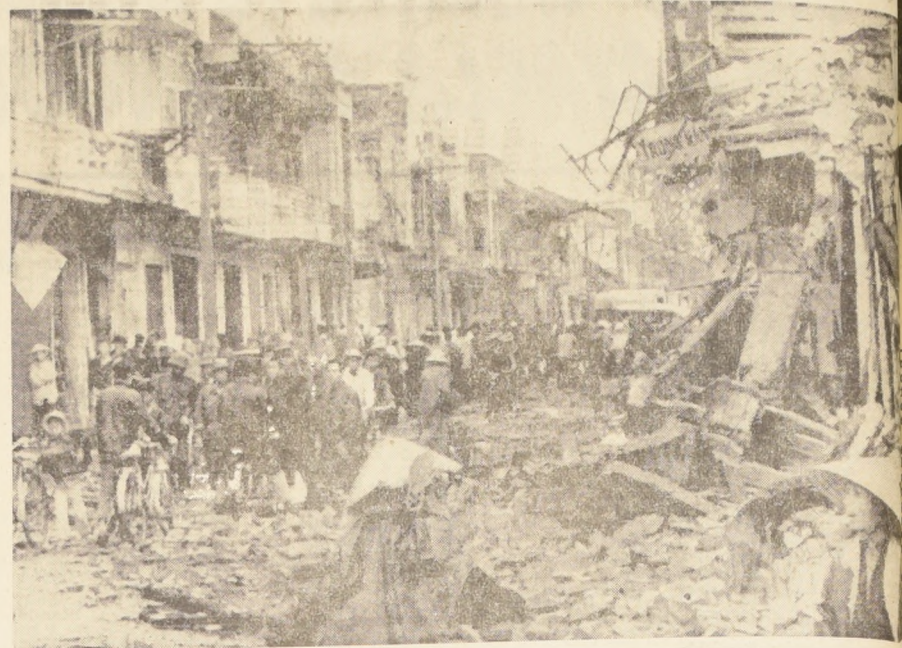
En Hue, destruida, residentes, refugiados y soldados caminan entre las ruinas de las calles de la ciudad. Los habitantes tratan de encontrar rastros de sus viviendas.— (Foto UPI).
