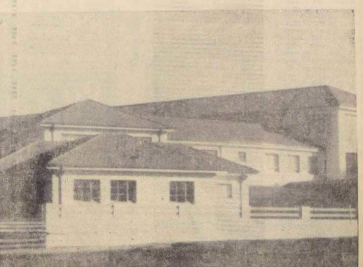
Una eficaz colaboración al plan de construcción escolar está dando el Departamento Regional de Arquitectura, que comprende las provincias de Malleco y Arauco, al prestar asesoría a las diversas obras que en este aspecto se realizan en la zona.
