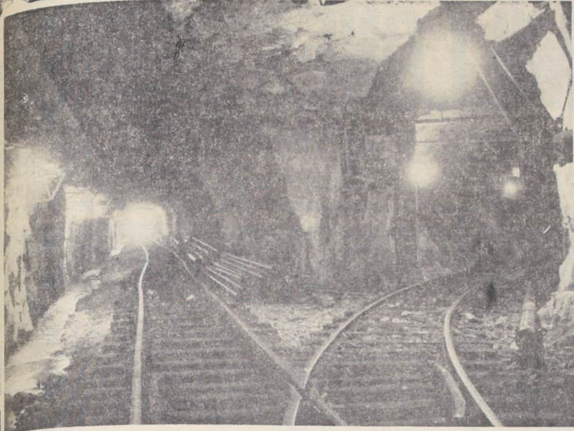
Una bifurcación de túneles en el interior de la Cordillera de los Andes, que se están construyendo para poner en explotación el mineral cuprero de Río Blanco
