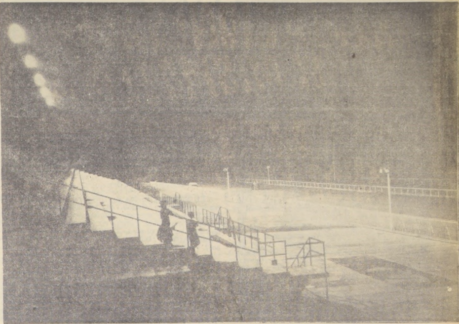
SEIS SOPORTES ubicados en la marquesina de galería, lanzan sus haces de luz hasta un sector de la recta palmeada. Un valioso aporte al progreso hípico será la iluminación total del óvalo del Hipódromo Chile.
