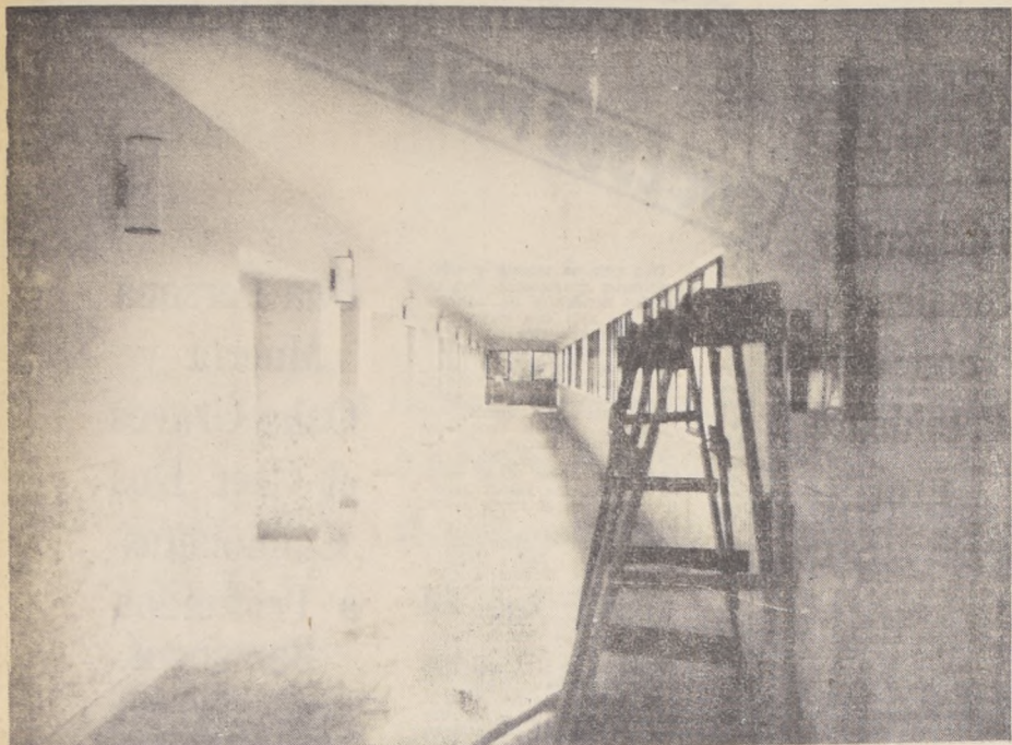
Un aspecto de los corredores cubiertos del edificio del Liceo de Hombres de Los Angeles que será inaugurado el sábado en la tarde por el Presidente Frei. Fue construido, por el Ministerio de Obras Públicas, a través de su Dirección de Arquitectura y dentro del Programa de la Alianza para el Progreso. Tiene capacidad para 1.400 alumnos y una superficie de 3.200 metros cuadrados.
