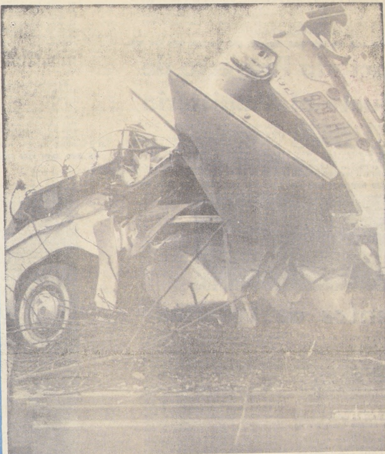
En este lamentable estado quedó un automóvil, que encontrándose estacionado frente al inmueble de calle Alonso de Córdoba 2348, fue embestido por un microbús de la 'locomoción colectiva'. La violencia del impacto también afectó a esa propiedad.
