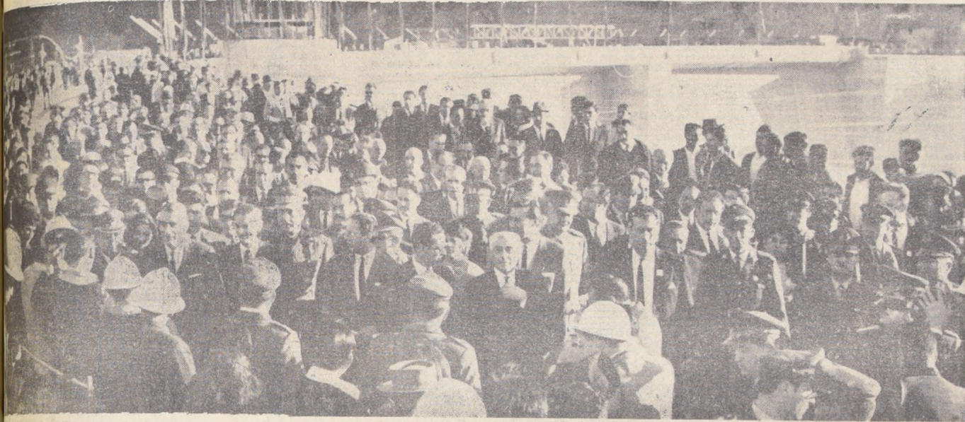
El botón accionado por el Presidente Frei puso en marcha, en la tarde de ayer, las turbinas de la Central Hidroeléctrica Rapel, obra de Ingeniería que permitirá acelerar el desarrollo del país, con sus 350.000 KW de potencia. En el grabado, un aspecto de la imponente obra.
