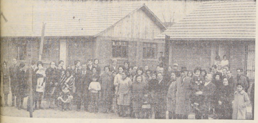
Un alto sentido comunitario y contando con el apoyo económico del Gobierno a través de CORHABIT y del Banco del Estado, los 252 socios de la Cooperativa "La Casa Propia Ltda.", construyeron sus viviendas en la población Kennedy para su uso las 42 restantes. Un grupo minoritario dentro de la población se ha negado últimamente a cancelar cuotas, pretextando que el canon de las viviendas es muy elevado. Estas, que fueron construidas con elementos de primera calidad, como las que observamos en la fotografía, se pudieron edificar con un costo que no alcanza los mil escudos. EN EL GRABADO, un grupo de pobladores posa feliz frente a la anhelada casa propia.
