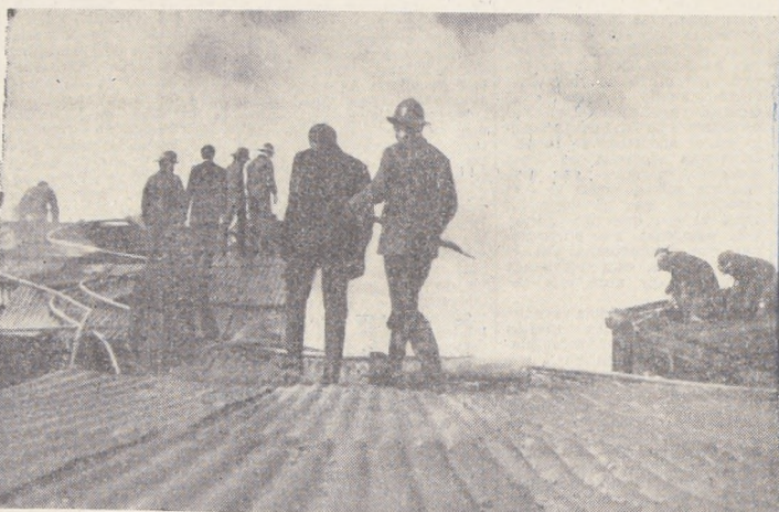
La escena corresponde al incendio que destruyó totalmente las bodegas de la Compañía Frutera "Chilena-Ecuatoriana", ubicada en Avenida La Paz y Andrés Bello.
