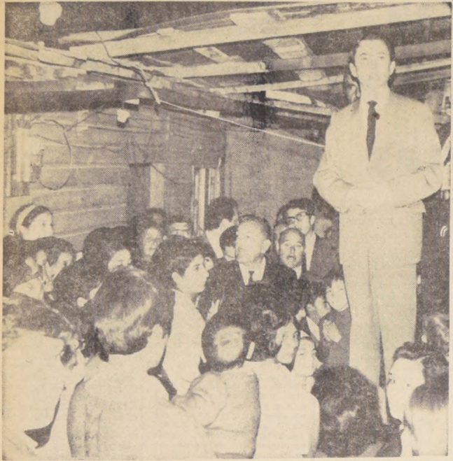
Juan Hamilton, Ministro de la Vivienda y Urbanismo, habla a los grupos familiares integrantes de la Cooperativa Autoconstrucción "Nandú" —San Miguel— que levantarán 240 casas, una escuela, sede social y áreas verdes, y fés agradece la confianza en los planes gubernamentales, a través del ahorro, como solución real a la vivienda propia.
