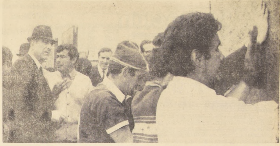
El Presidente Frei fue ayer a la Población "Renca" y presenció cómo un grupo de obreros, trabajando por el sistema de autoconstrucción, levantaba el armazón de una nueva vivienda en sólo 15 minutos.
