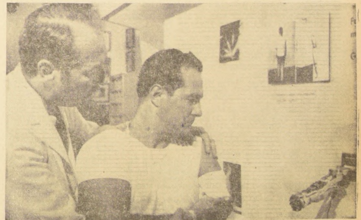
Los doctores Alan Cudworth y Melvin Glimpcher, del Hospital General de Massachusetts, guían a sus pacientes Parker Rand y Rudolph Paquin, mientras aprenden a usar el maravilloso "Brazo de Boston", prótesis que permite accionar un brazo electromecánico mediante los impulsos emitidos por el cerebro. El flujo nervioso acciona delicados dispositivos electrónicos que dan al brazo artificial casi todos los movimientos y posibilidades de uno natural. (Foto UPI.)
