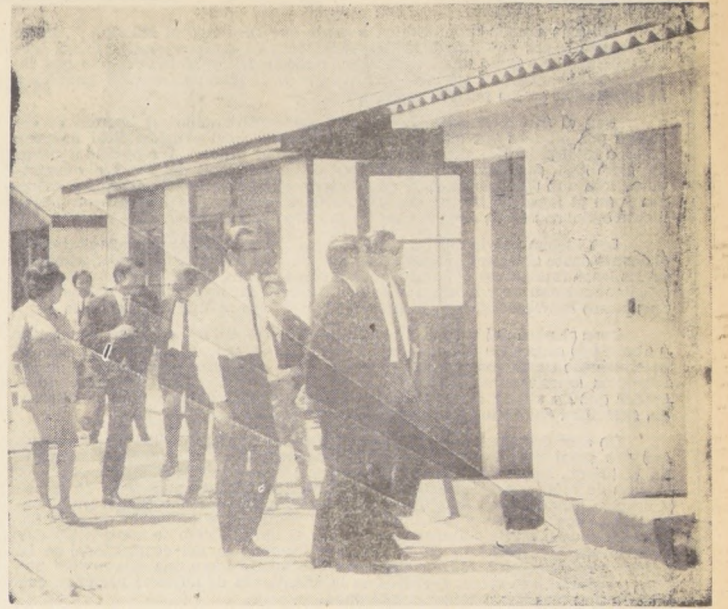
El Ministro de la Vivienda y Urbanismo, Andrés Donoso, —primer plano en el grabado— observa una de las casas que se construyen mediante el sistema "Operación Sitio", en la populosa comuna Las Barrancas. Aparece acompañado por funcionarios de su Secretaría de Estado.
