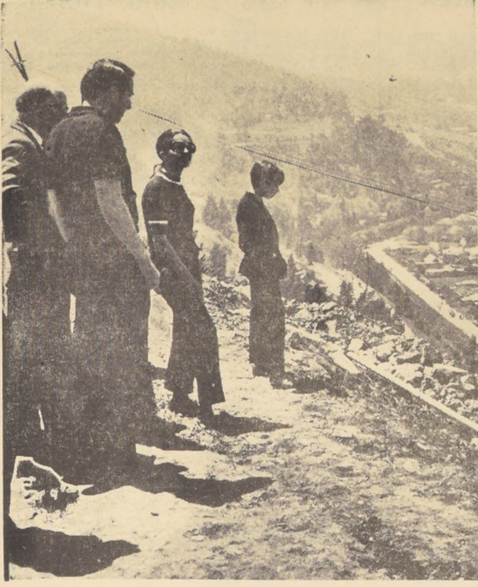
El Ministro de la Vivienda y Urbanismo, Andrés Donoso Larrain, en su visita al Parque Metropolitano, observa los trabajos de adelanto en dicha área verde capitalina.
