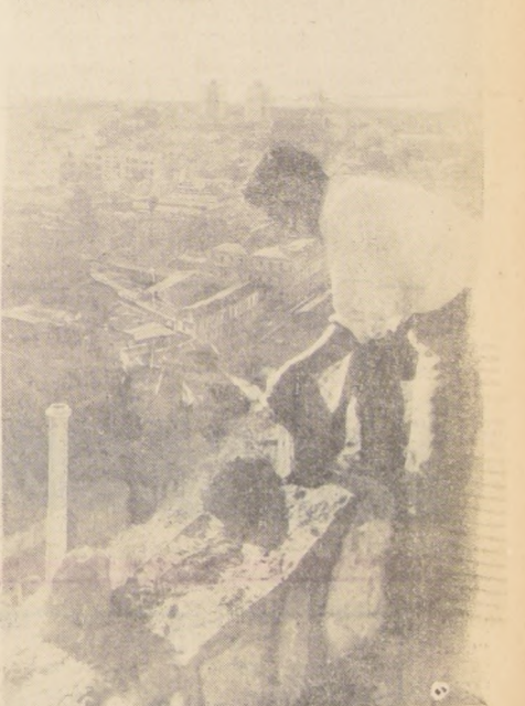
Un obrero levanta piedra a piedra un gran muro de contención, de los miles que se han debido construir en la parte alta de Valparaíso, para ir dando forma a la ciudad que se eleva hacia los cerros.
