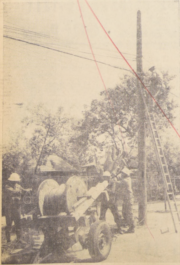
Trabajo en tendedero de cable telefónico aéreo en la comuna de Las Condes. Funcionarios de la Compañía de Teléfonos trabajan arduamente a través del territorio en las diferentes facetas que abarca el plan de ampliaciones que permitirá sumar 190.000 nuevos teléfonos a los ya existentes en el país.
