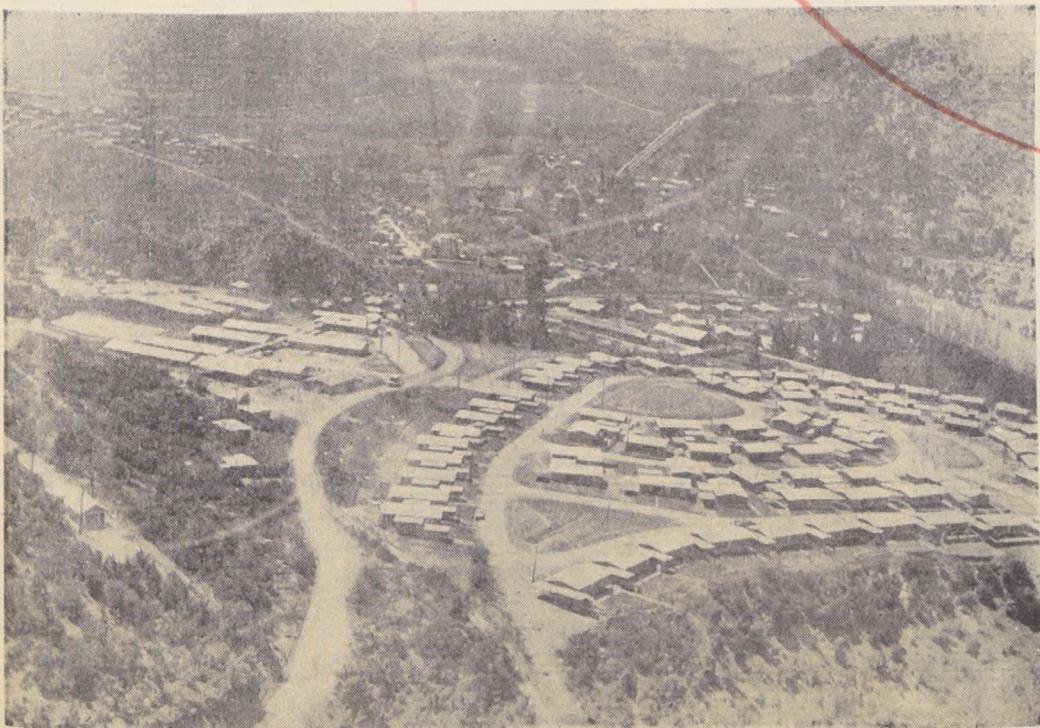
La construcción de viviendas marcha aparejada a la ampliación de la planta.
