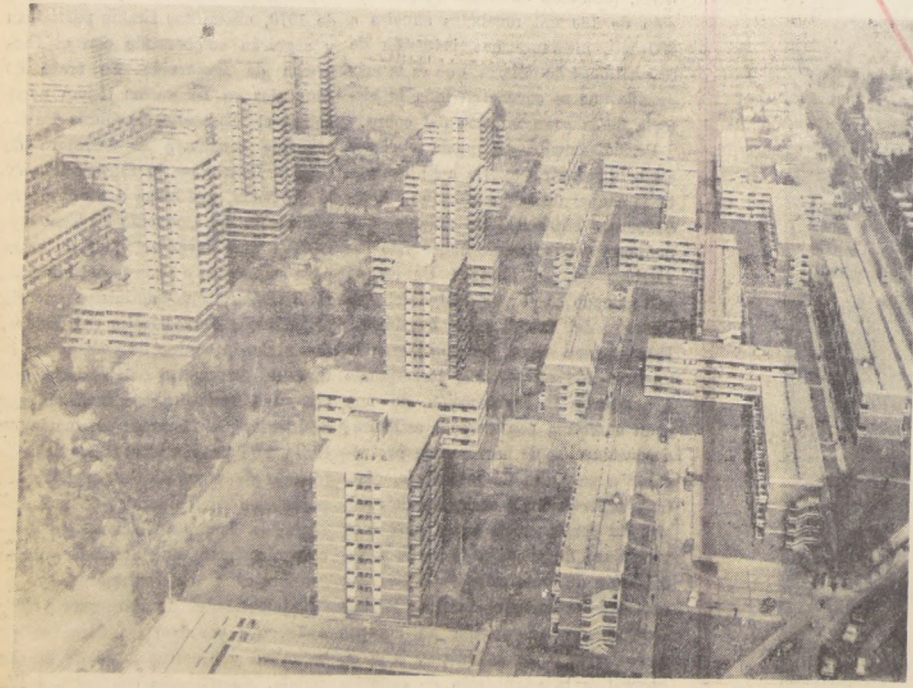
VILLA "PRESIDENTE FREI", construida por COR VI. 3.818 viviendas y equipamiento comunitario tal.
