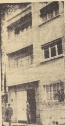
Este es el edificio de departamentos en Alonso Ovalle No. 846, en donde murió brutalmente asesinada la profesora jubilada María Adela Raquel Gacitúa Gullén, el día 1 de noviembre próximo pasado. Tres sospechosos, una mujer y un chino, entre ellos, estarían implicados y la BH, sigilosamente, verifica sus actos antes y después del Día de Todos los Santos.
