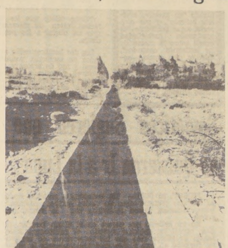
El revestimiento del canal unificado del valle de Putaendo es una de las importantes obras de infraestructura de riego efectuadas por el Servicio Agrícola y Ganadero
