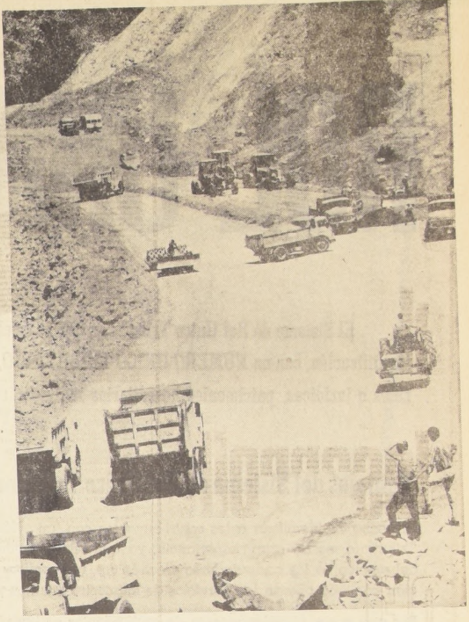
Despejes de terreno en plena cordillera. Ruta de Coya a Colón.
