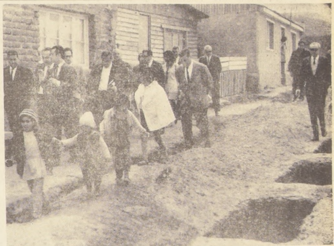
El Alcalde de Valparaíso, Juan Rodríguez López, en compañía del diputado Osvaldo Giannini, de técnicos municipales y vecinos, inspecciona los trabajos de instalación de alcantarillado en la Población Chile, del cerro Esperanza, ejecutados por la Empresa Municipal de Desagües.
