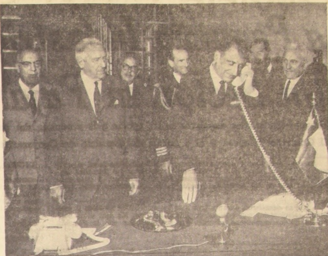
El Presidente Frei inauguró a fines de diciembre pasado, las obras de ampliación de las centrales telefónicas de Principal III y Maipú, poniendo en marcha seis mil seiscientos nuevos teléfonos. A su izquierda aparecen el Presidente de la Compañía, don Ernesto Barros Jarpa y el Gerente General, señor Benjamin W. Holmes.
