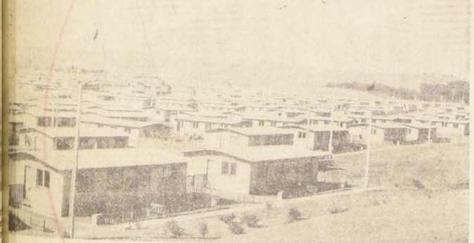
LAS DUNAS, SAN ANTONIO.- Como esta población se levantan centenares construidas por CORVI para los sectores modestos.
