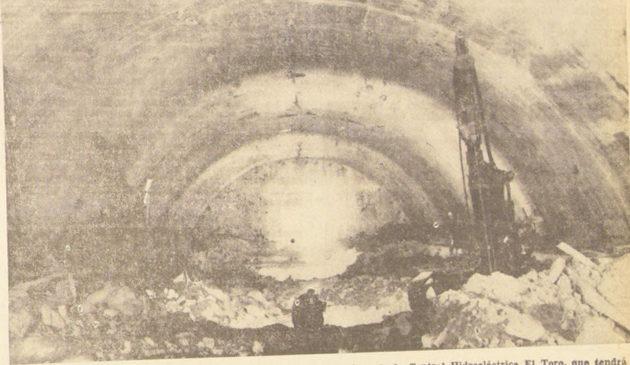
Caverna de la Casa de Máquinas de la Central Hidroeléctrica El Toro, que tendrá una potencia de 400.000 kw.
