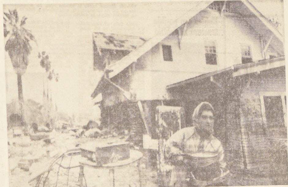
AZUSA, CALIFORNIA.— Un deslizamiento de tierras destruye habitaciones y enseres causando cuantiosos daños en casas que pasan del millón de dólares.
