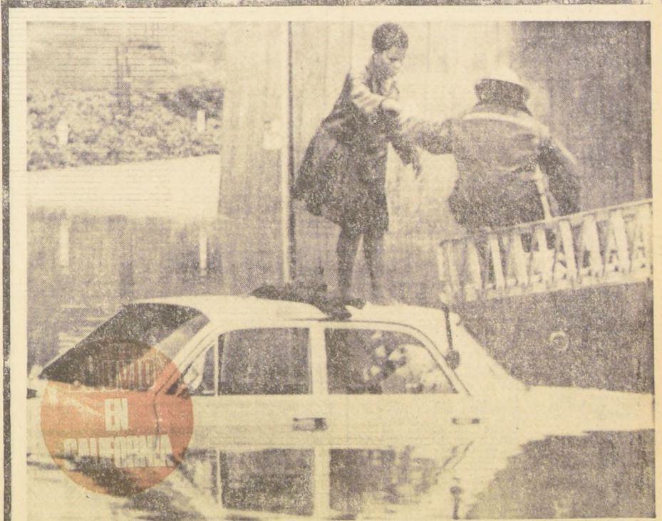
California ha sido afectada por una de las peores inundaciones de que haya recuerdo. Éamnos y casas destruidos por nueve días de torrenciales lluvias. Centenares de millones de dólares en pérdidas. La escena muestra un sitio inundado. El automóvil, casi totalmente bajo las aguas, da una idea de la magnitud del desastre.
