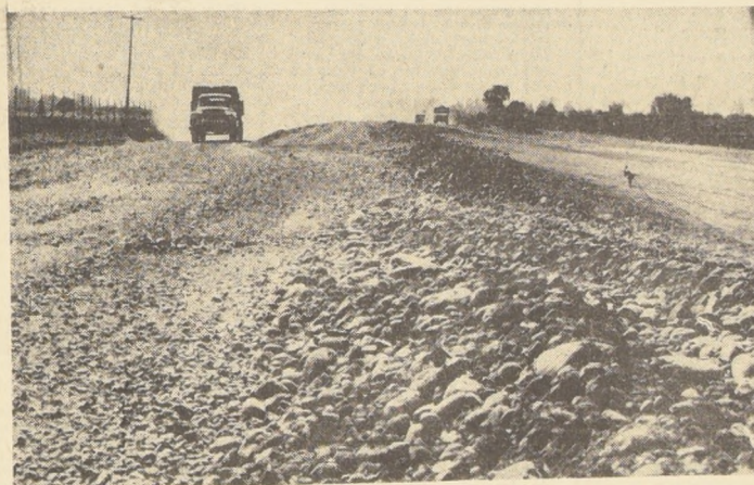
NUEVO CAMINO A SAN ANTONIO.— Una nueva carretera de dos pistas de alta velocidad, que acortará en varios kilómetros el camino a San Antonio, se encuentra construyendo la Dirección de Vialidad en el tramo comprendido entre el Paico y Padre Hurtado. Las pistas tienen una amplitud de siete metros, totalmente cerrada, especialmente adaptada a altas velocidades. Los caminos transversales a la nueva carretera pasarán bajo nivel y la línea del ferrocarril hará por encima de ella. Las obras estarán totalmente terminadas a principios de 1970.
