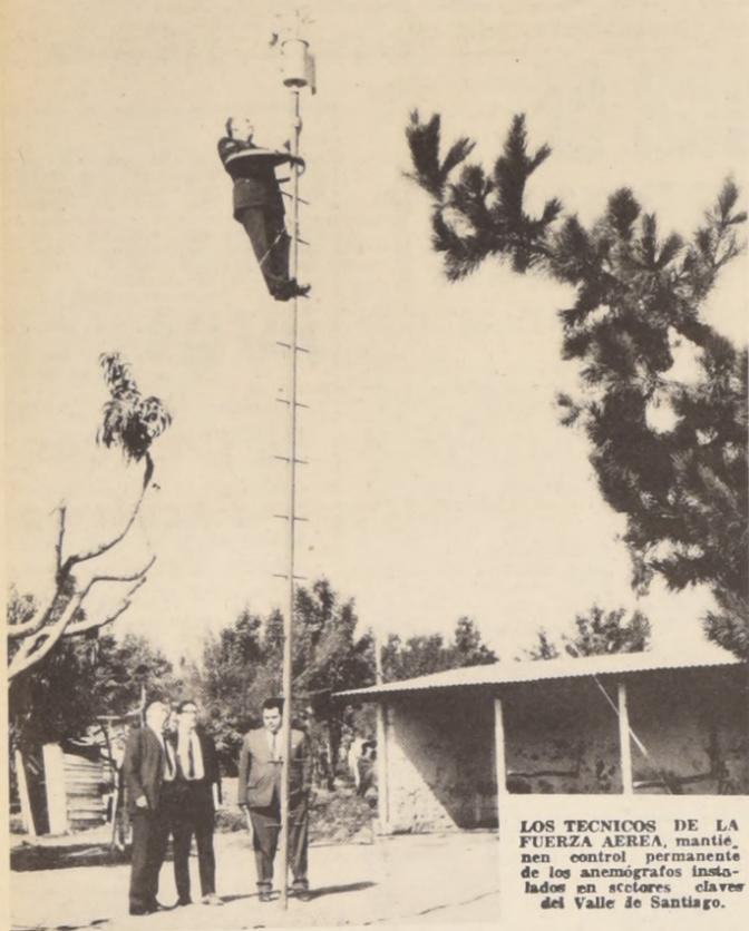
LOS TECNICOS DE LA FUERZA AEREA, mantienen control permanente de los anemógrafos instalados en sectores claves del Valle de Santiago.
