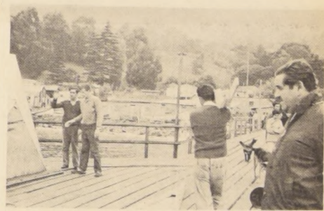
Faena de descarga de los paneles de las treinta viviendas prefabricadas, en el muelle de Juan Fernández. A la derecha, el Gerente de la Corporación de Servicios Habitacionales, Gastón Díaz Muñoz.
