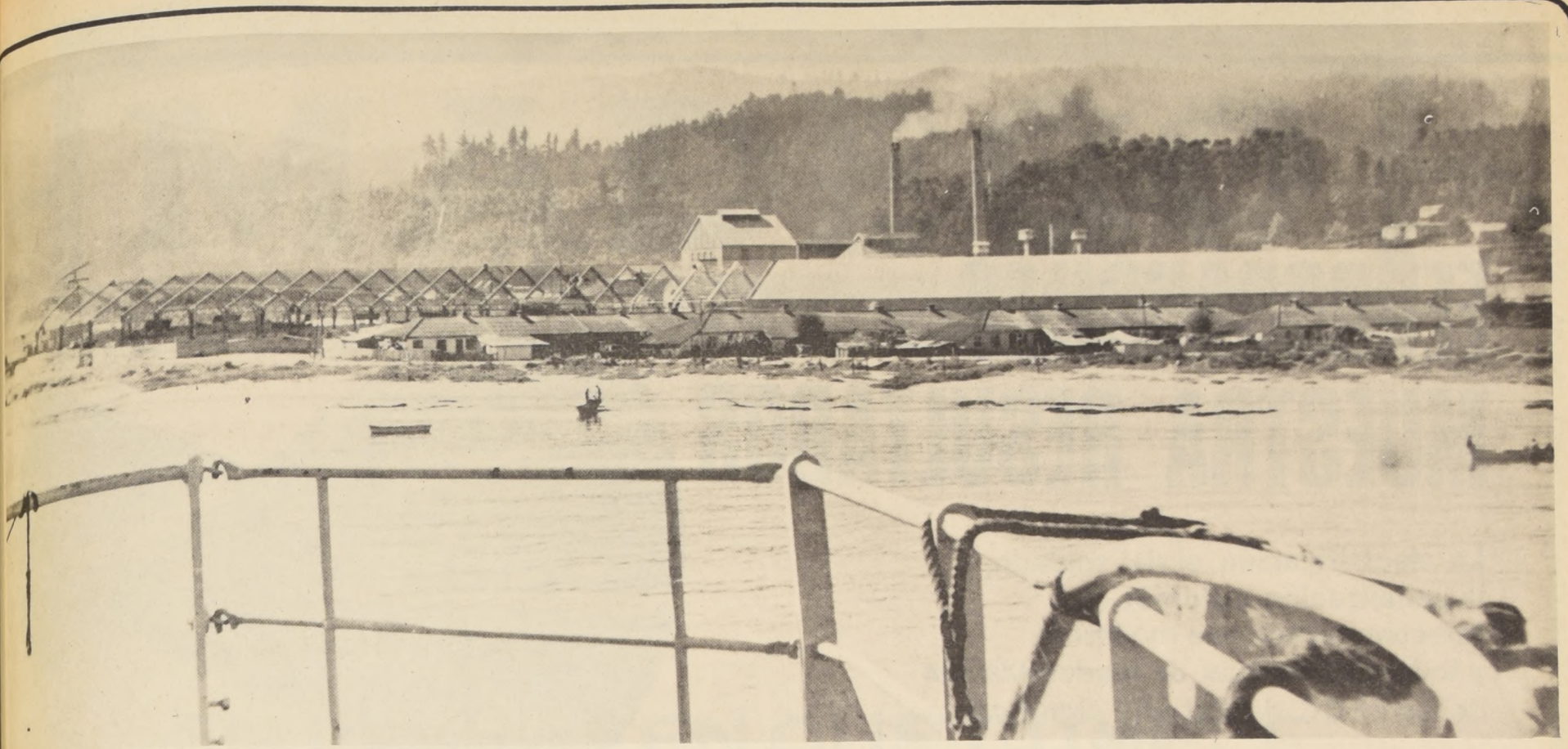
Vista de las Instalaciones Portuarias en el Muelle de LIRQUEN que está Siendo Mecanizado con un Préstamo CORFO.
