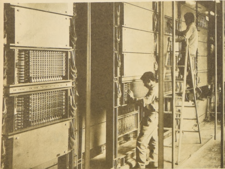
Trabajos de montaje de los equipos del Sistema Pentaconta, el más moderno que existe actualmente en materia de conmutación telefónica automática, y que se encuentran funcionando en la mayoría de las ampliaciones recientemente puestas en marcha.
