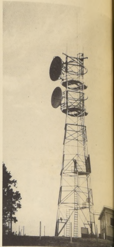
Torre de microonda de Recreo Alto, una de las terminales de este moderno sistema de comunicaciones que une a Santiago con Valparaíso. Chile fue el primer país sudamericano de la costa del Pacífico en emplear las microondas en las comunicaciones telefónicas.
