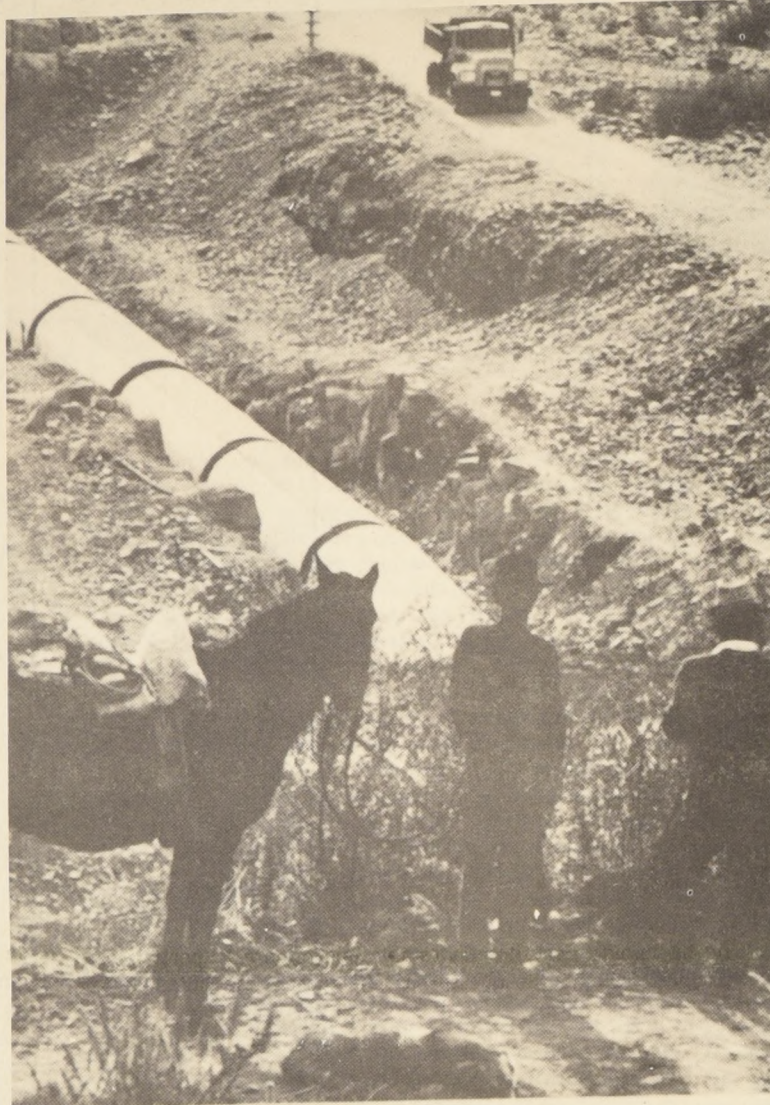
A lo largo de los caminos la tubería lleva el petróleo.
