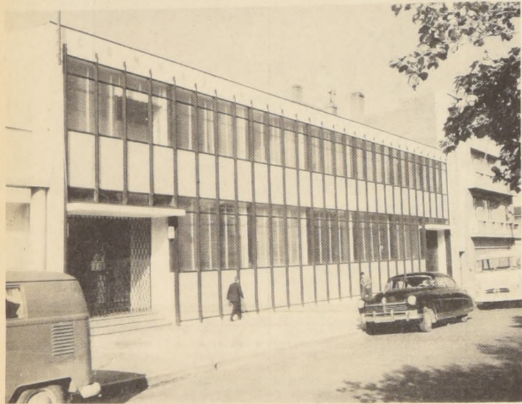
Decenas de teléfonos públicos, de acera como el que aparece en la fotografía están funcionando en las distintas comunas de la capital. Servicios similares empezarán a instalarse en las principales ciudades del país. Abajo, la fachada del edificio en que funciona la Central Telefónica de Punta Arenas, la más austral del mundo.
