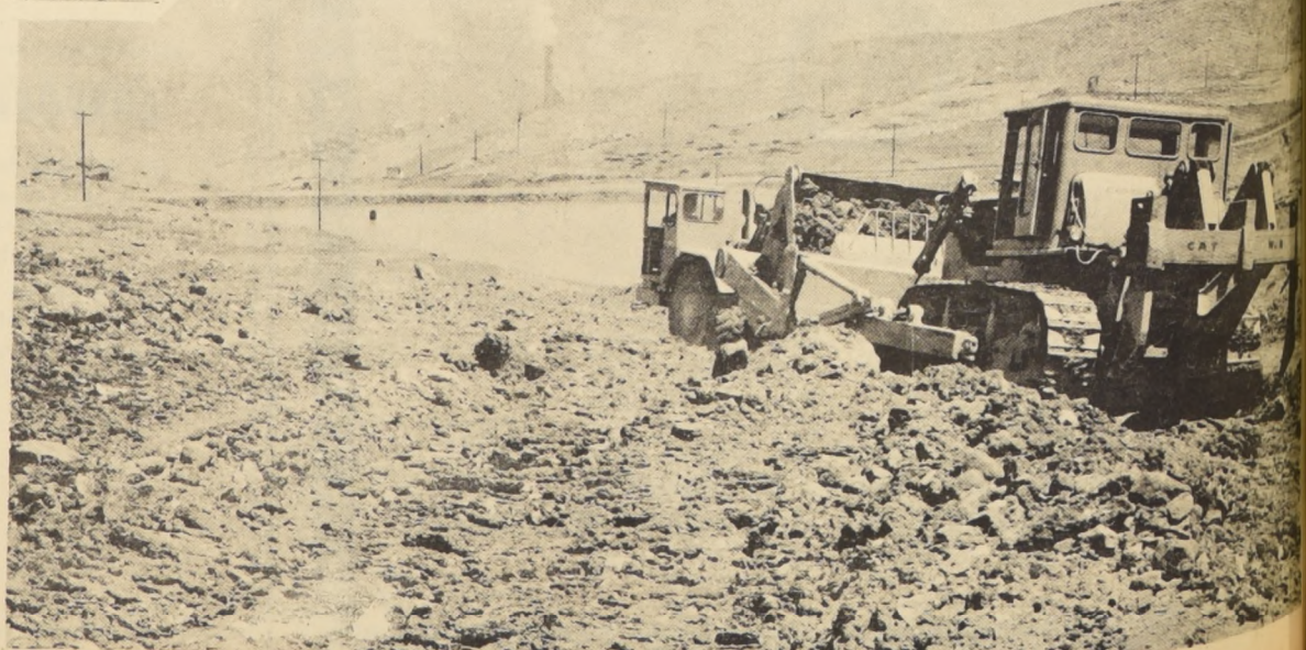
Las dos fotografías de la parte superior de la página muestran, la de la izquierda, el Grupo Electrógeno Diesel, instalado en pocos meses para hacer frente a los efectos de la sequía. A la derecha se abren los heridos para las fundaciones del futuro concentrador de Colón. Sector inferior de la plana, a la izquierda, la Nueva Entrada a la Mina El Teniente, ubicada a ocho kilómetros de los piques actuales. A la derecha, un carterpillar acoplado a una pala mecánica trabajan en el movimiento de tierras en el gigantesco complejo de Colón. Al fondo, izquierda, una blanca humareda pone una nota fabril en el paisaje. Es la chimenea de la Fundición de Caletones.
