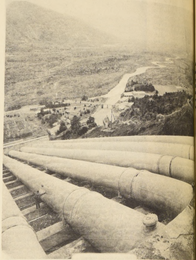
EL ABANICO: Las tuberías de la Central Hidroeléctrica de "El Abanico", otra de las centrales en explotación de ENDESA. Produce 136.000 KW.
