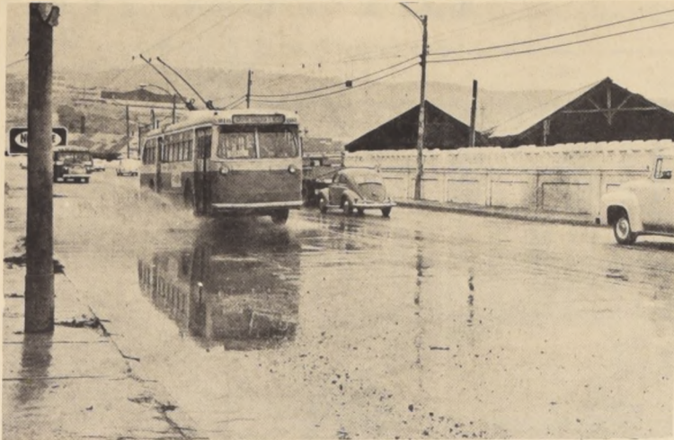
LA AVENIDA ESPAÑA quedará relegada a un segundo plano con la construcción de la vía elevada que unirá Valparaíso y Viña.
