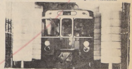
Instalación para el lavado de trenes del Ferrocarril Metropolitano de Milan.
