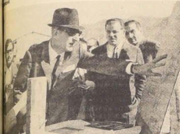
MAÑANA DEL SABADO, el Presidente Frei recorrió en Chuquibambilla las obras de la planta de Filtros de Sales del Carmen, que se inició en funciones a comienzos de 1970. En el grabado, el Presidente observa los planos de la obra en ejecución en compañía del ingeniero jefe y técnicos que tienen a su cargo los trabajos.
