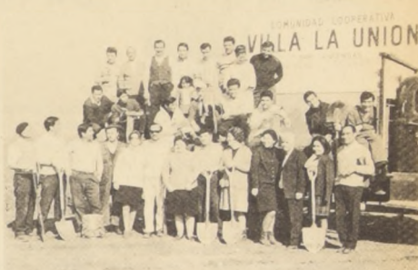
GRUPO DE COOPERADOS de "Villa La Unión", junto a los directivos Pedro Jofré, Mario Castro, Pedro Jiménez, Rolando Mariángel y José Villegas, con palas y chuzos, empajando el terreno de su futura población. Esta labor la cumple los sábados por la tarde y los domingos, horas del descanso de su trabajo cotidiano.
