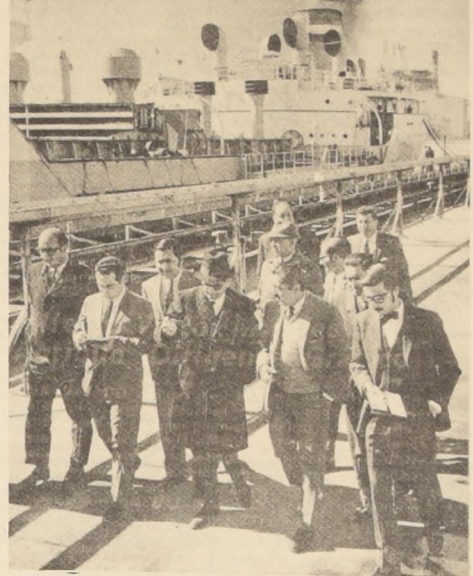
"ESTE MUELLE... explica a LA NACION el ingeniero Rafael Covarrubias: fue construido para satisfacer las necesidades de nuestra planta termoeléctrica. Ahora comenzará a prestar servicios a dos industrias vitales del país: el cobre y el cemento." Por Ventanas cargarán y descargarán barcos de alto tonelaje.
