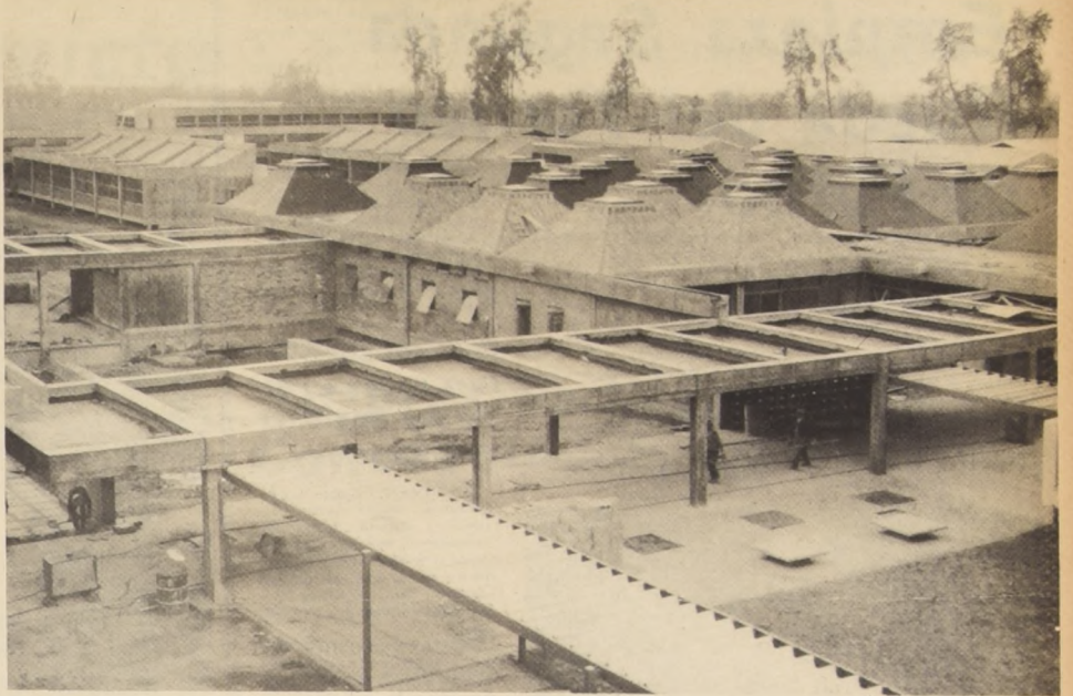
POCO A POCO van terminándose las edificaciones de la nueva sede de la Facultad de Agronomía de la Universidad de Chile, en el fundo "Antumapu". Junto a ella se iniciará posteriormente la construcción de la Facultad de Ciencias Pecuarias.
