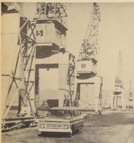
DE LA MODERNIZACION DE LAS OBRAS PORTUARIAS DEPENDE EN MUCHO EL DESARROLLO DE ESTA CIUDAD PARA LA CUAL SU ALCALDE Y SU MUNICIPIO PROPICIAN UN PLAN DE PROGRESO Y DESARROLLO
