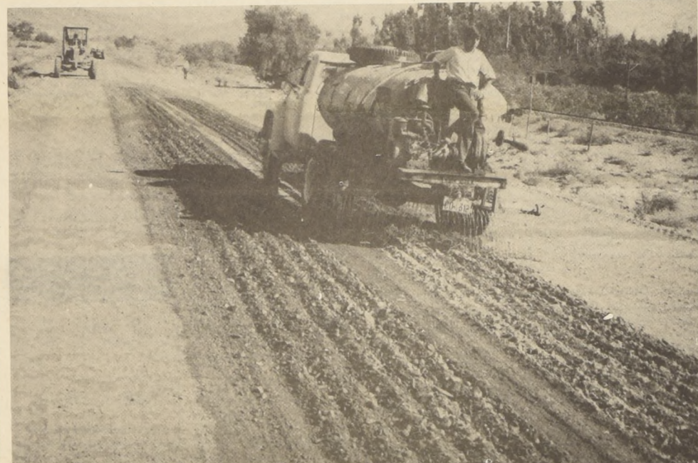
ACELERADAMENTE se está trabajando en la construcción del camino que unirá a Imperial con Temuco, importante obra de vialidad que será
