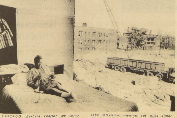
CHICAGO. Barbara Pearson lee cómodamente sentada en su cama, mientras los obreros que derribaron accidentalmente la pared de su dormitorio continúan adelante con su obra de demolición. Hace unos días, miraba televisión, mientras sus hijos
