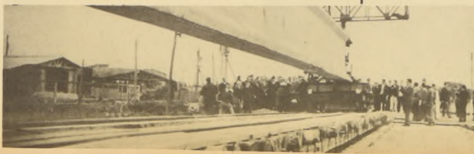
PUENTE SOBRE EL BIO-BIO - Impresionado por la magnitud de la obra de 2.300 metros de longitud del nuevo puente sobre el río Bio-Bio, el Primer Mandatario inspeccionó los trabajos acompañado del Ministro de Obras Públicas y Transportes, Eugenio Celedón.
