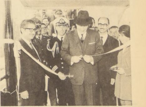
INAUGURACION.— El Presidente Frei corta la cinta colocada a la entrada de la sala de máquinas de la planta de "La Mochita", inaugurando de esta manera la obra que permitirá abastecer de agua a Concepción y Talcahuano. Se soluciona de esta manera durante este Gobierno, un problema que afectaba a dos ciudades de indudables perspectivas para el futuro.
