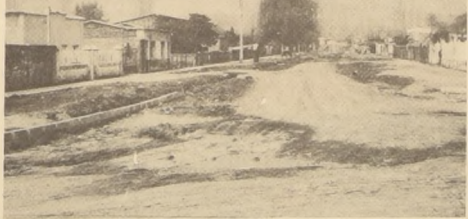
Calle sin pavimento, verdaderos lodazales en invierno y polvaredas en verano.
