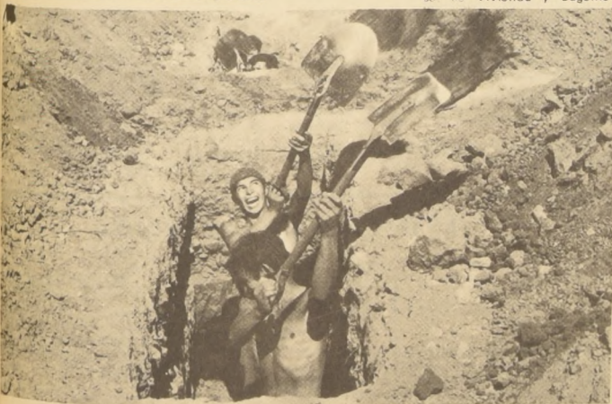
Con entusiasmo los habitantes de San Luis de Macul comenzaron los trabajos de autoconstrucción...
