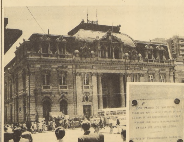
El viejo edificio que fue residencia de los gobernantes chilenos hasta 1846, sirve hoy de oficina postal.
