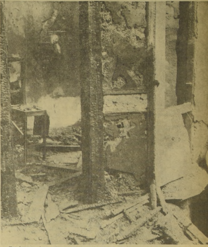
Totalmente destruido quedó el inmueble donde funcionaba la CUT Provincial, en calle República N.º 27, por un incendio que fue atribuido a una bomba incendiaria. El fuego también afectó a dos casas colindantes arrendadas por el Partido Demócrata Cristiano, resultando damnificadas tres familias
