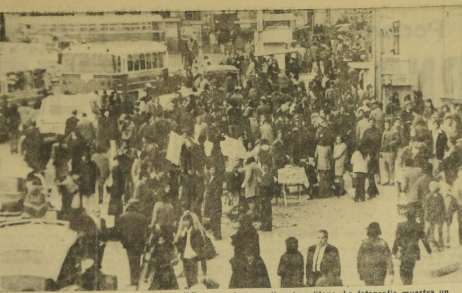
Grandes incomodidades debe soportar el público que espera locomoción cerca de la Estación Central. A los de transporte, se agrega el mal estado de aceras y calzadas, producto de los trabajos de construcción del ferrocarril metropolitano. La fotografía muestra un aspecto del acceso al recinto ferroviario y las dificultades que deben afrontar las personas que por obligación deben transitar por el sector.
