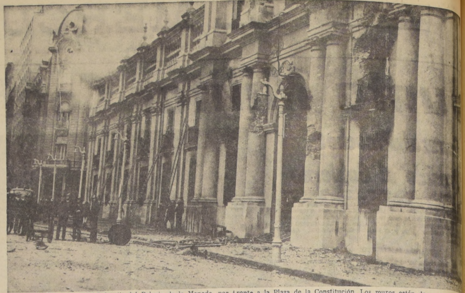
Otro aspecto del frontis del Palacio de la Moneda, por trefante a la Plaza de la Constitución. Los muros están dañados por el fuego y las balas militares
