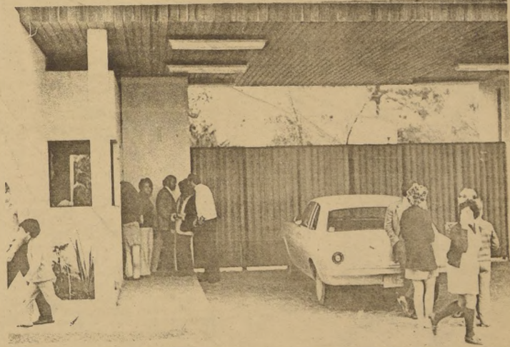
EN LA FOTOGRAFIA se aprecian algunas ventanas rotas. El portón principal, sin embargo, quedó intacto. Adentro cayeron algunos muros y se soltaron las puertas de lo que fue la fortaleza presidencial.
